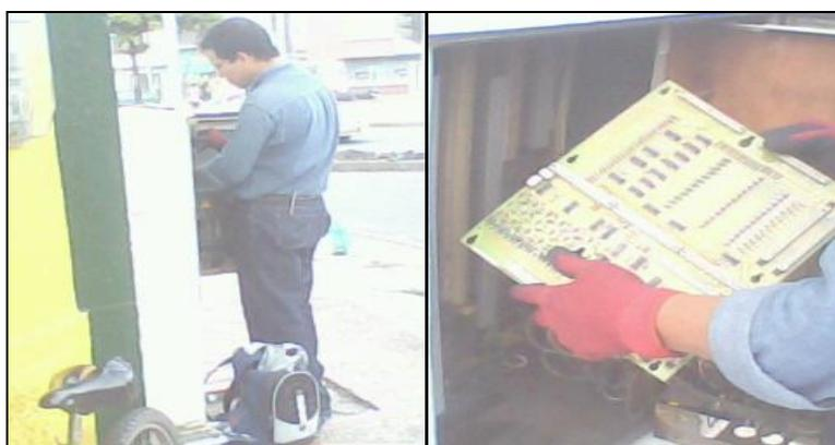
Se encontró intermitente el cruce de la calle 52 con Carrera 17. Se repotenció el controlador GE SIEMENS, cambiándole las tarjetas electrónicas: Una tarjeta electrónica PRO, cinco tarjetas ELD.
